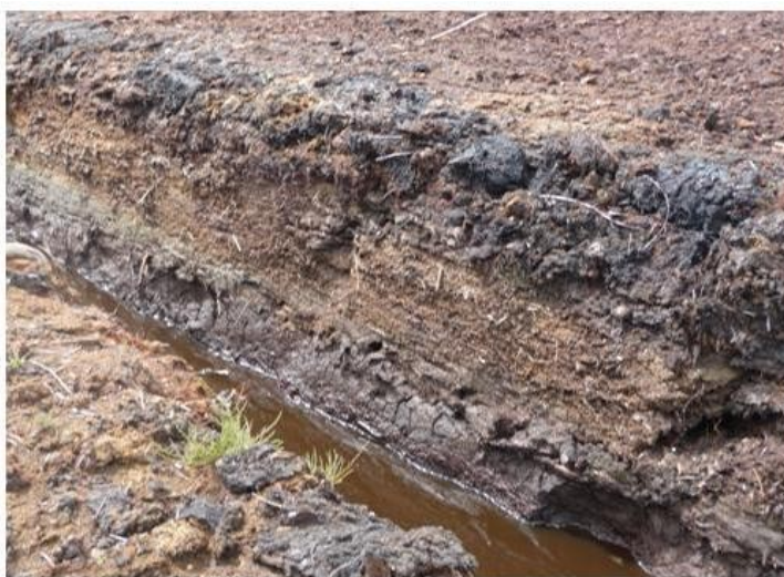
Рис. 129. Откос канала, видна слоистость торфяной залежи
