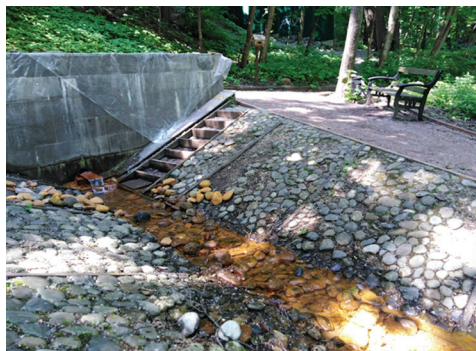
Рис. 9. Каптированный родник и русло ручья после проведённых работ по укреплению. Фото В.А. Алексеевой.
