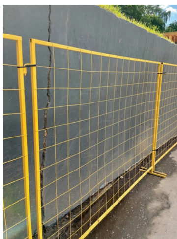
Рис. 17. Подпорная стенка канатной дороги, июнь 2021 г. Фото И.П. Таранец.
