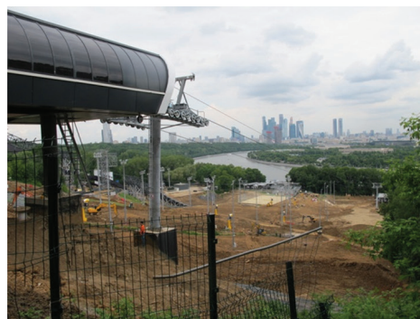
Рис. 16. Стройка на Воробьёвых горах, июнь 2022 г. Фото В.А. Алексеевой.
