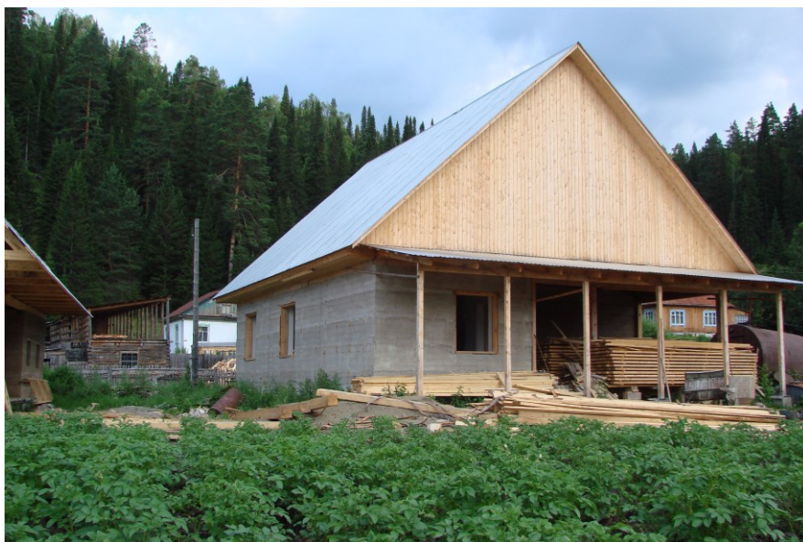
Рис. 149. Сруб дома из торфяных плит
